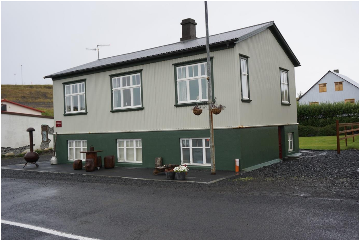
Mynd 38. Ólafshús sumarið 2017. Húsið er byggt af Ólafi Jónssyni árið 1924 á grunni eldra og minna húss sem bar sama nafn. Húsið hefur verið endurgert sem næst upprunalegri mynd. Mynd: Benjamín Kristinsson.
