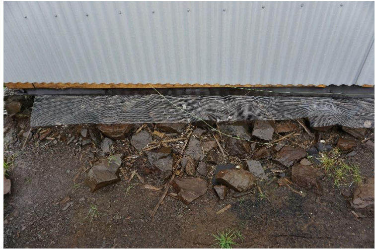
Mynd 61. Tómasarbær er byggður árið 1935 á grunni eldri torfbæjar sem stóð á sama stað og bar sama nafn. Grunnurinn er hlaðinn úr steingrýti. Mynd tekin af Benjamín Kristinssyni sumarið 2017.
